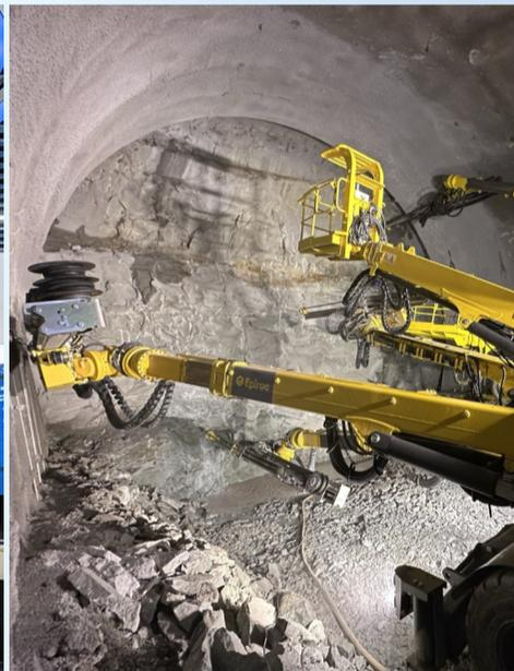
智能三臂凿岩台车进行隧道大断面掘进
