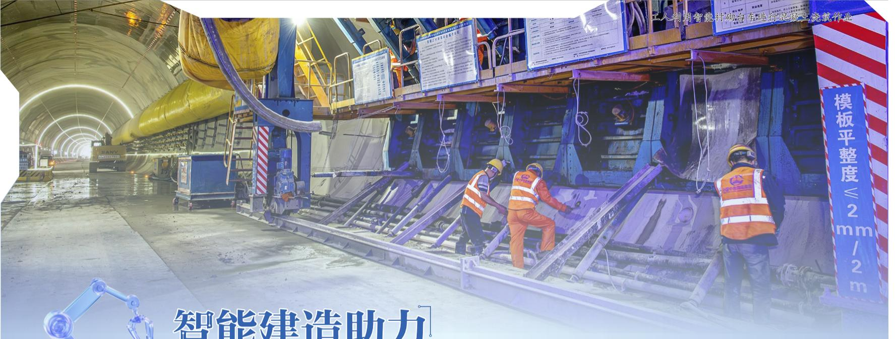
工人利用智能衬砌台车进行混凝土浇筑作业
