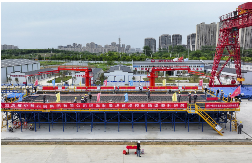
首榀双线箱梁浇筑现场航拍
