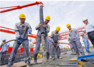
工人正在进行混凝土浇筑作业
