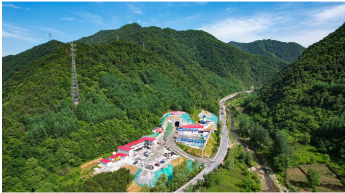
天陇铁路徐家坪隧道出口航拍
