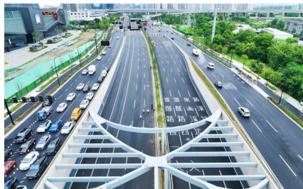
杭州市文一西路西延工程地下隧道通车
