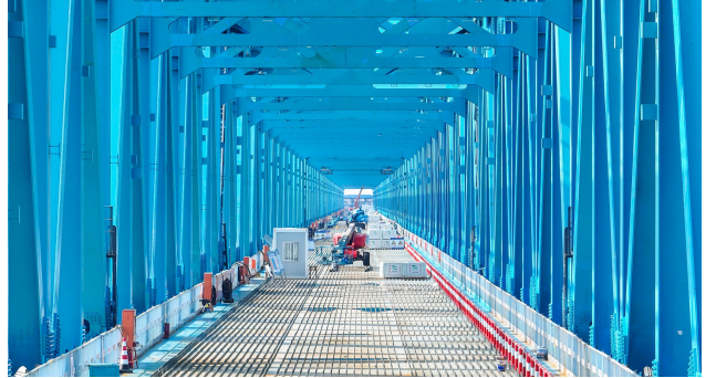
黄河特大桥内部掠影
