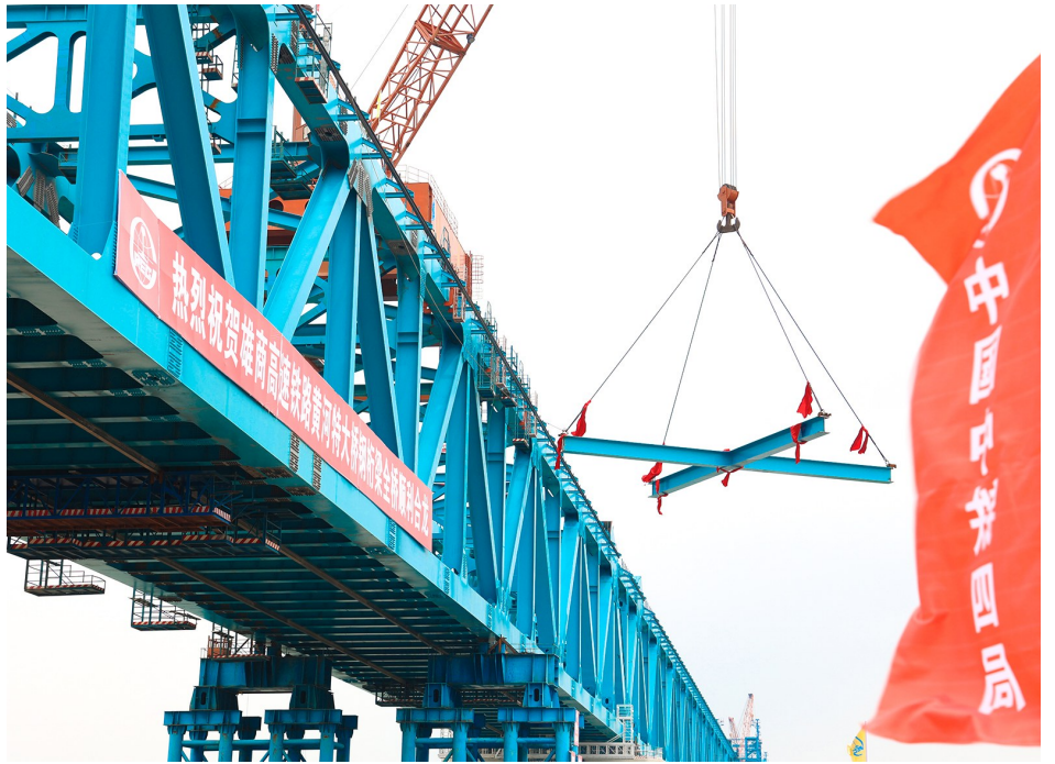
黄河特大桥最后一根钢桁梁起吊
