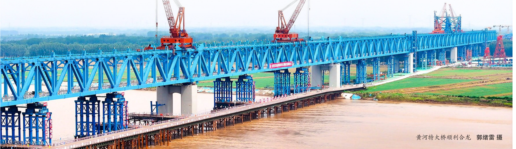
黄河特大桥柔性拱拼接施工现场
