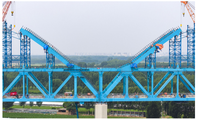
黄河特大桥柔性拱
