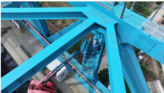
工人正在进行喷涂作业
