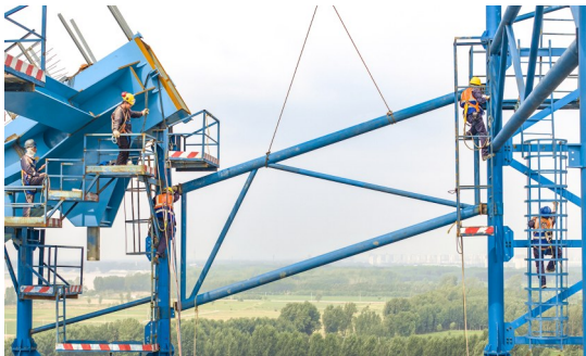
黄河特大桥柔性拱拼接施工现场
