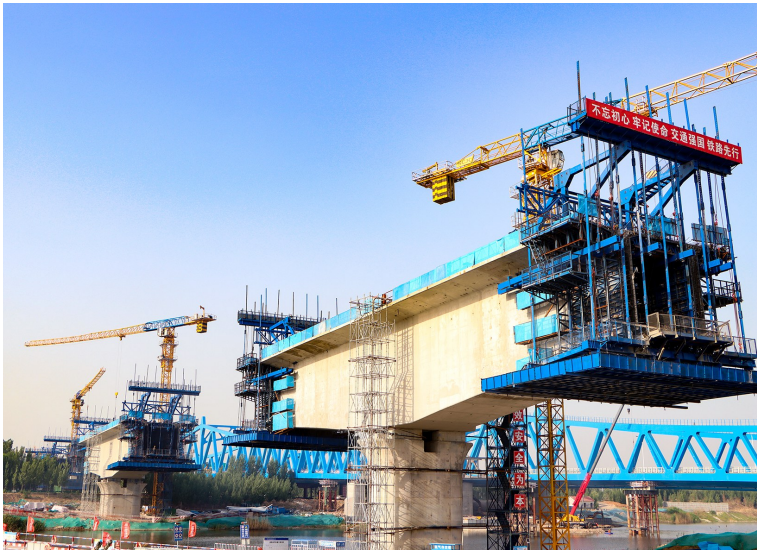
►济南(滨州)高铁济南东特大桥道岔梁施工现场
