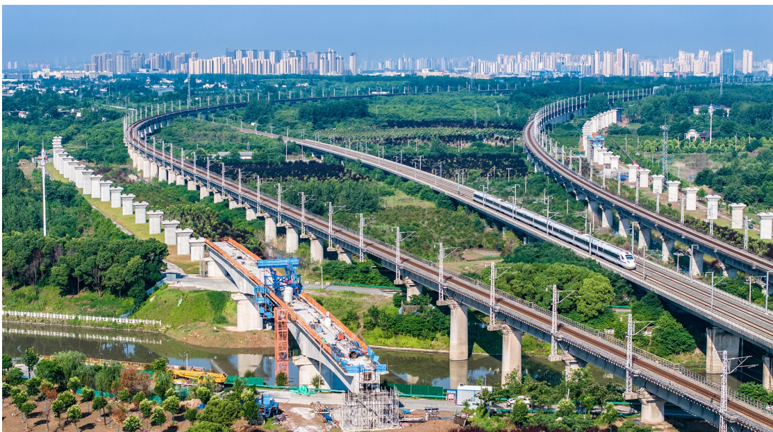
►沪(上海)宁(南京)合(肥)高速铁路引入合肥枢纽工程左线首个连续梁顺利合龙
