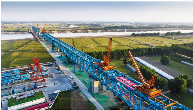
建设中的京雄商高铁黄河特大桥
