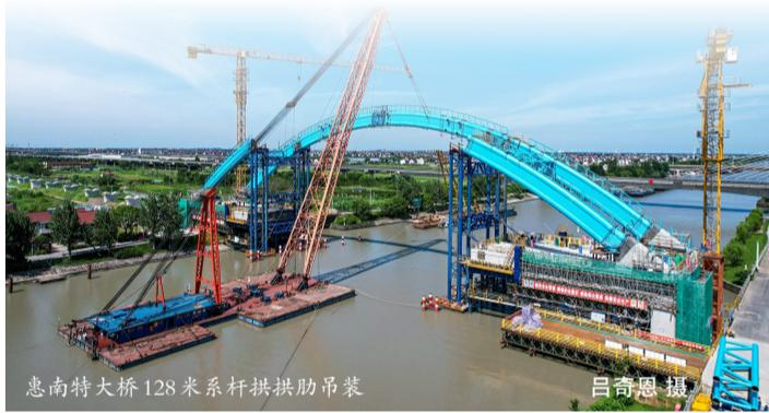
惠南特大桥128米系杆拱拱脚吊装
