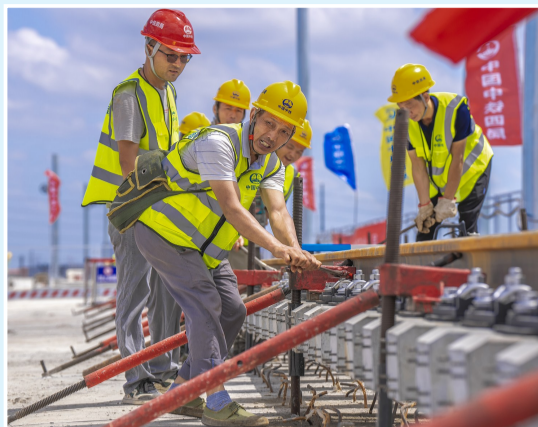
工人正在固定轨道胶垫板及其它配件
