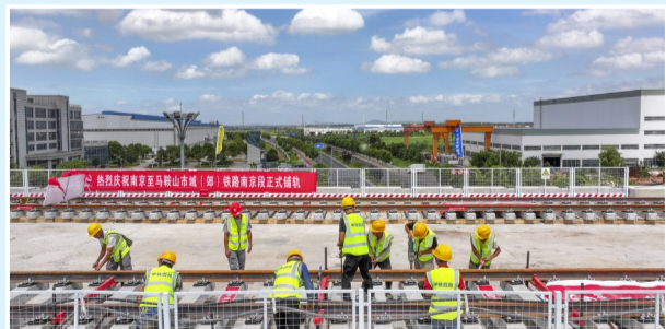
工人正在紧固螺栓
