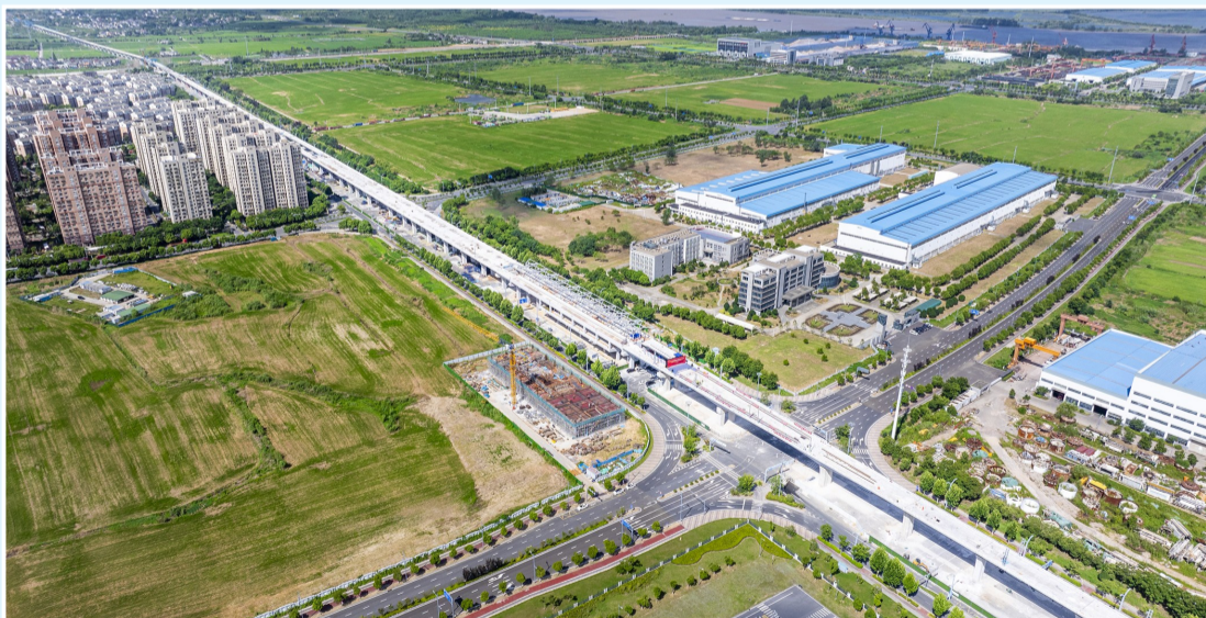
建设中的宁马城际铁路南京段
