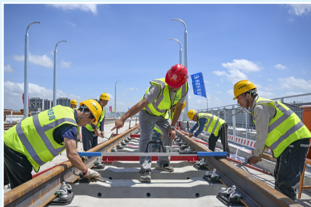
施工人员指挥现场作业
