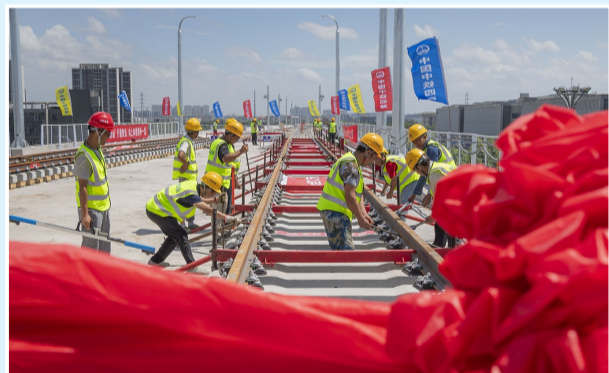
铺轨施工作业中
