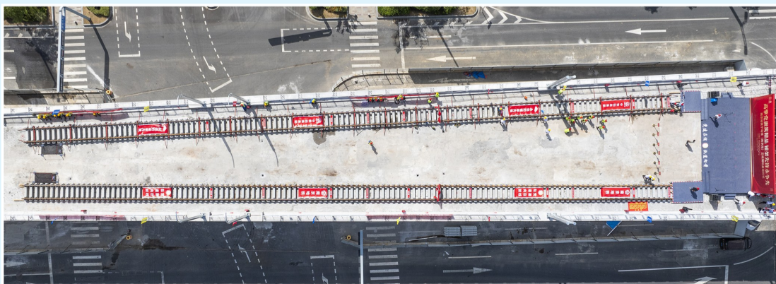
铺轨作业现场
