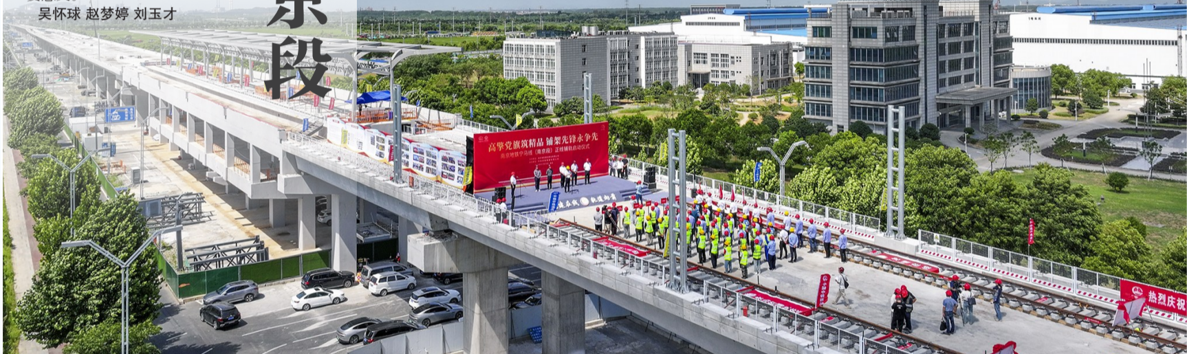
宁马城际铁路南京段铺轨启动仪式现场
