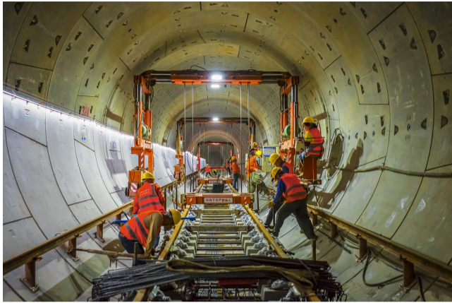
铺轨机在进行铺轨作业
