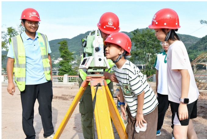
余秋雨摄 “小候鸟”在施工人员的指导下体验观察测绘仪器
