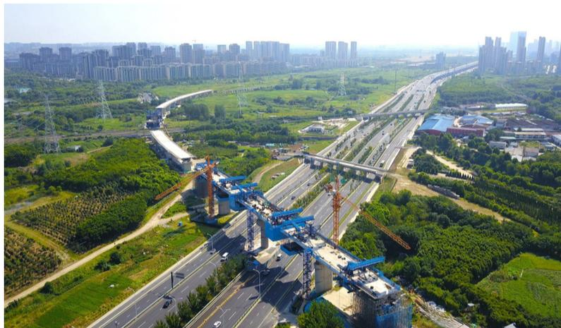
8月3日,中铁四局四公司承建的合(肥)安(庆)铁路引入合肥枢纽3标包公大道特大桥跨包公大道连续梁边跨合龙。包公大道特大桥全长138米,采用悬臂浇筑施工,其合龙段采取刚性骨架临时固结施工工艺,按照“先边跨合龙、后中跨合龙”的顺序实现全桥合龙。
