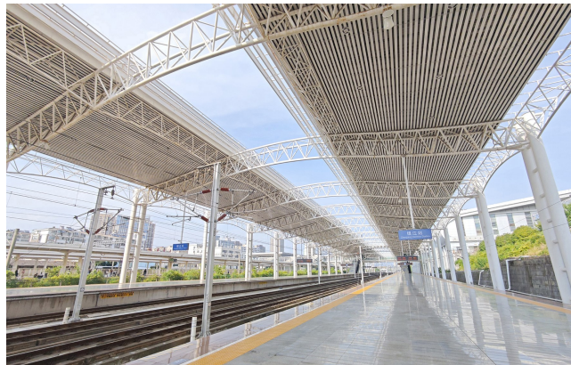
镇江站雨棚维修项目
