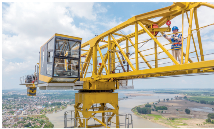
女工班组塔吊司机赵双利对塔吊进行检查
