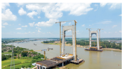
G329国道凤阳至蚌埠改线工程临淮关淮河大桥施工现场航拍 刘玉才摄
