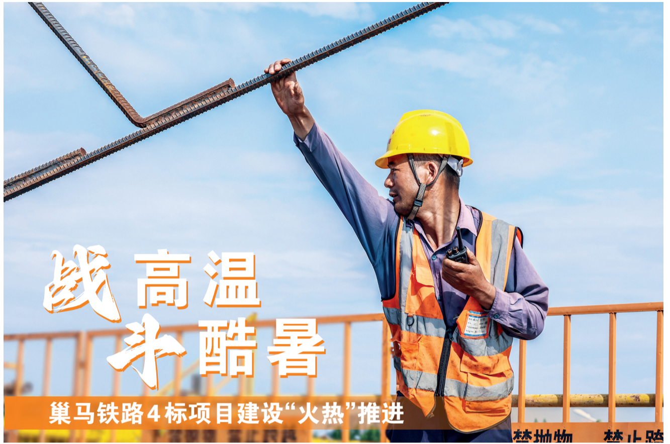
工人正在指挥钢筋吊送
