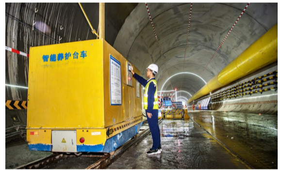
智能养护台车进行隧道衬砌喷淋养护
