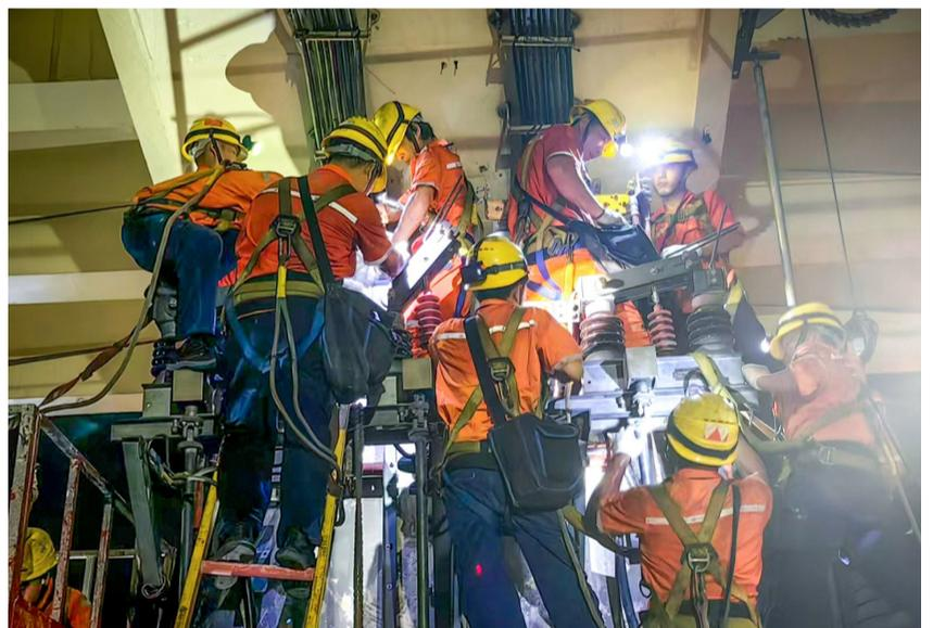
8月22日，中铁四局电气化公司承担的上上海轨道交通1号线北延伸段共康路站一体化高架段轨道交通接触网隔离开关更换完成。上海轨道交通1号线北延伸段全长12.43公里，开通至今运行近20年，为确保设备可靠性和提升运营质量，对轨道交通接触网隔离开关等设备进行更换。
