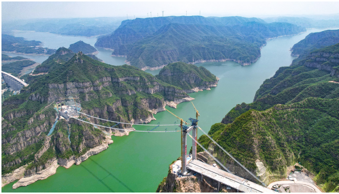
史家民 摄 建设中的济(源)新(安)高速公路黄河大桥
