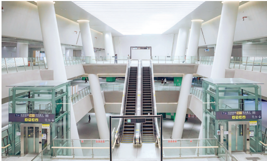
中铁四局五公司参建的深圳市黄木岗交通枢纽“V”柱空间荣获2022年度ITA地下空间创新贡献奖
