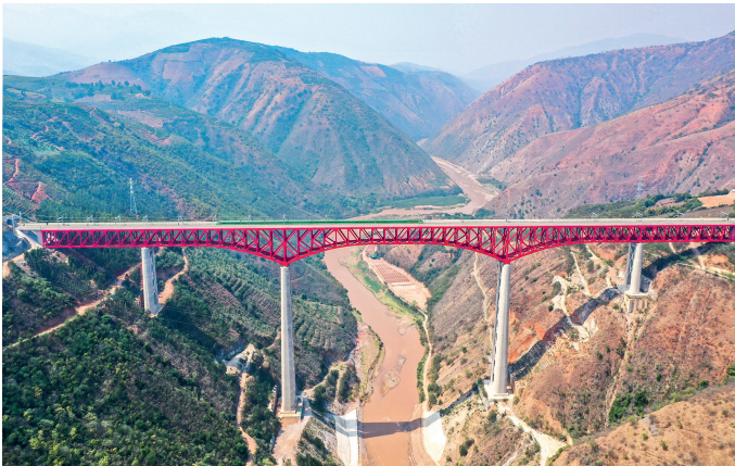
中铁四局承建的中老昆万铁路玉(溪)磨(憨)段元江双线特大桥,是世界跨度最大的上承式连续钢桁梁铁路桥
