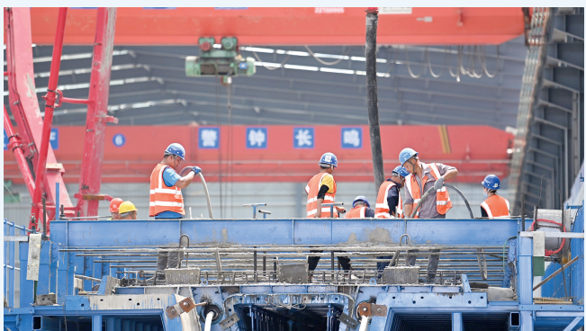
工人正在进行预制箱梁模板混凝土浇筑及振捣作业
