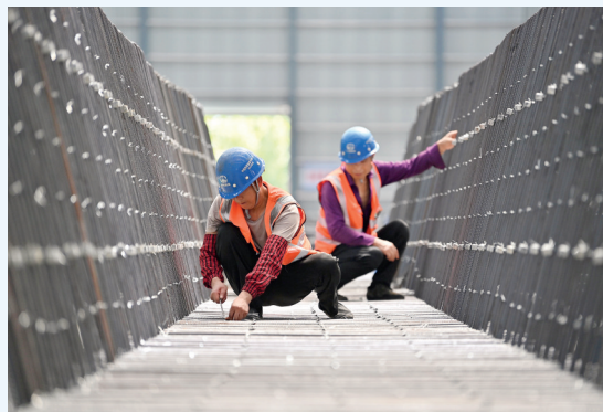
工人正在进行预制盖梁钢筋绑扎作业
