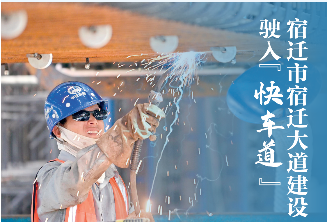
工人正在进行钢筋焊接作业
