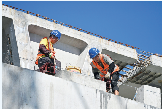
工人正在进行垫石凿毛施工
