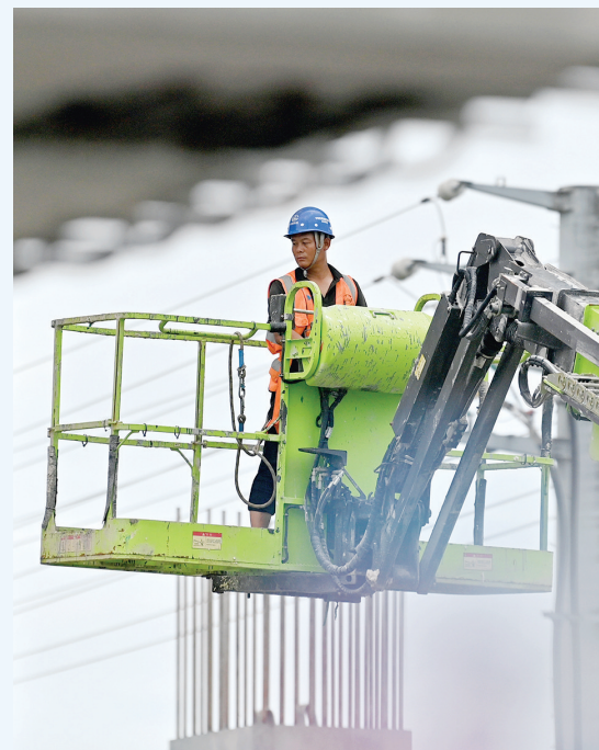
工人正在检修墩柱
