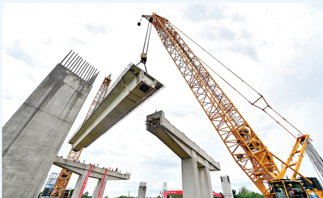
全线首件预制盖梁架设现场
