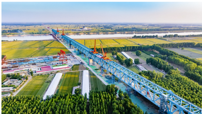
建设中的(北)京雄(安新区)商(丘)高铁黄河特大桥
