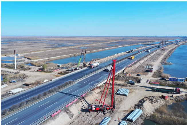
对软土路基处理段预应力管桩进行振动锤击
