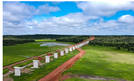
在建的几内亚马西铁路尼日尔河大桥墩身群 袁奕昕 摄
