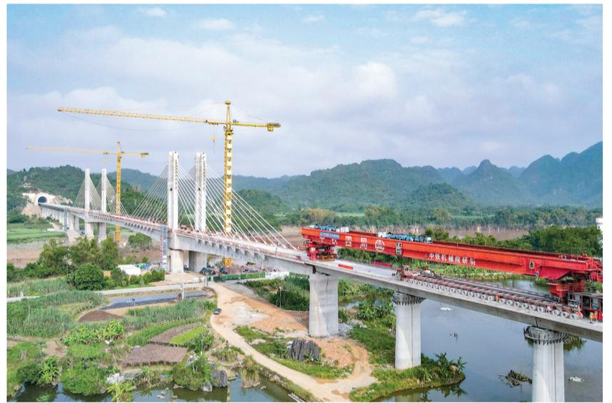
9月15日，中铁四局承建的南(宁)凭(祥)高速铁路崇左至凭祥段1标箱梁架设完成。该标段全长19.904公里，施工内容包括桥梁、隧道、路基、附属设施等，共需预制架设箱梁711孔。 徐江丽 唐娜 摄
