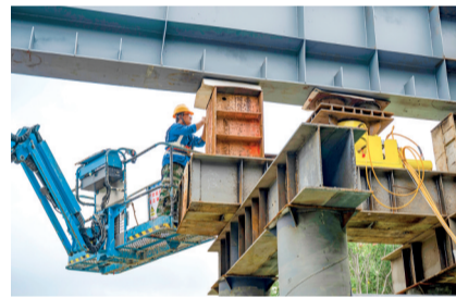
技术人员正在进行顶推作业
