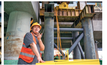
作业人员沟通现场顶推情况
