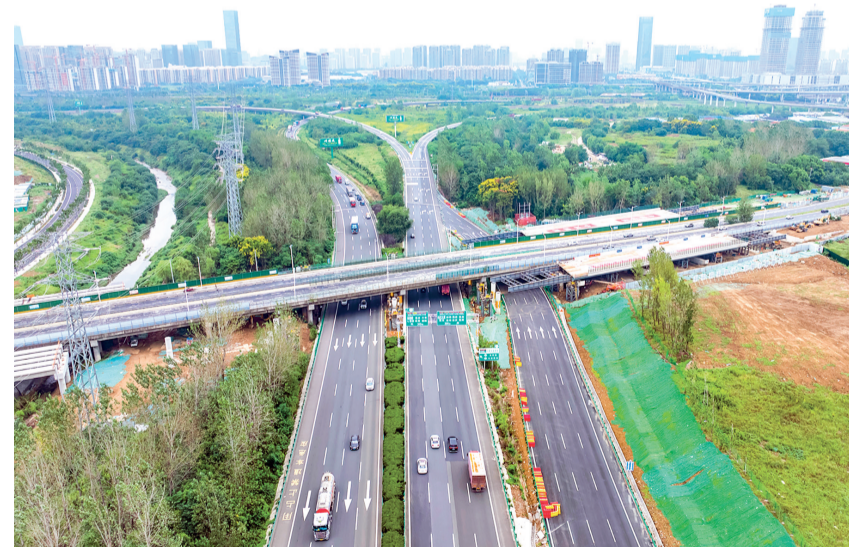
沪汉蓉桥改造工程项目钢箱梁顶推现场
