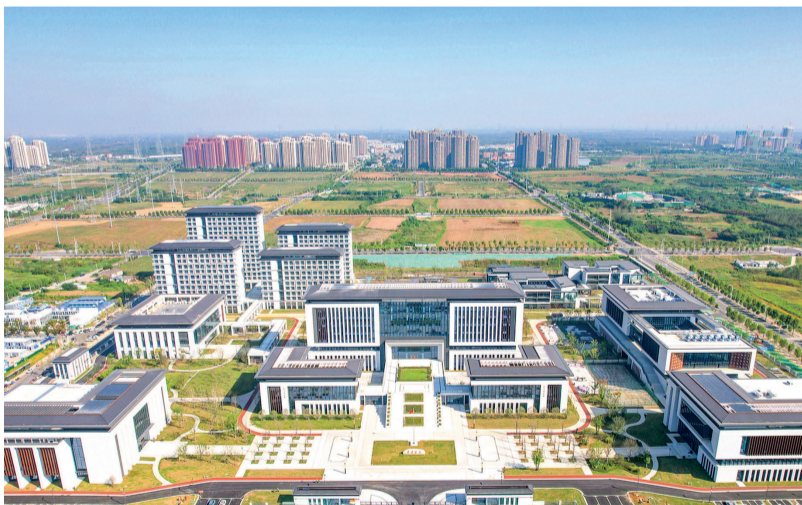
9月19日，由中铁四局建筑公司承建的中共合肥市委党校(行政学院)新校区项目投入使用。该项目位于合肥运河新城核心区，总建筑面积14.3万平方米，可容纳1500名学员在校培训及300名研究生学习。 卢勇龙 高亚迪 摄
