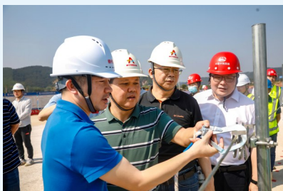
观摩人员了解桥涵工程
