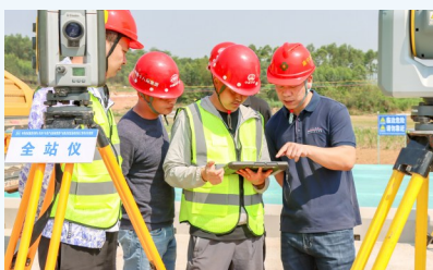
观摩人员了解3D无桩化智能摊铺工艺
