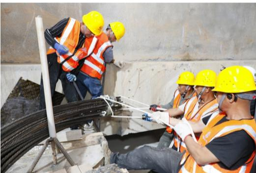
工人正在调整张拉钢绞线末端位置
