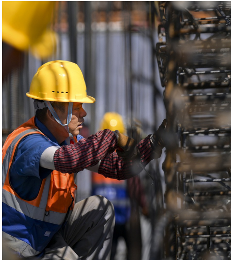
合肥三水厂项目部作业人员正在绑扎预氧接触池钢筋 刘玉才 摄
