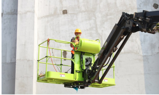
南昌市下罗粮管所项目部工人正在进行粮库外墙保温作业 刘燕 摄
