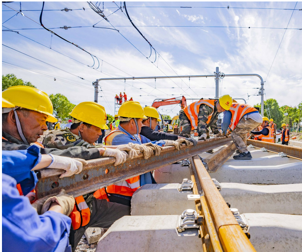
上海轨道交通13号线项目部作业人员正在移动拆卸后的钢轨 赵梦婷 摄
