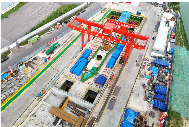
钢铁厂站盾构掘进施工
