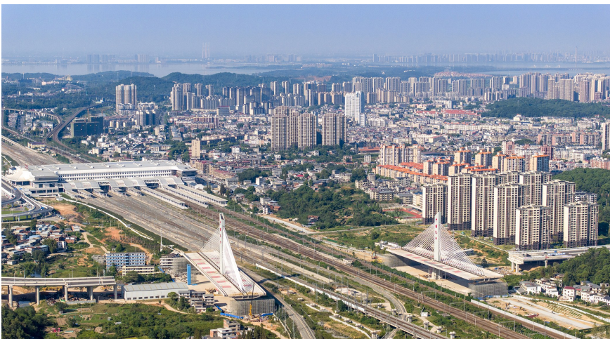
九江快速路跨庐山站转体斜拉桥试转体完成
