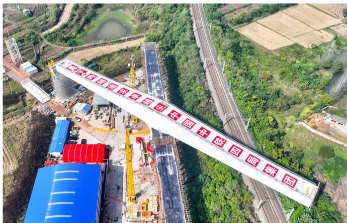
10月23日,中铁四局一公司承建的黄冈市长胶廊道上跨京九铁路大桥3号墩T构梁转体完成。此次转体的T构梁长148米、重9000吨,是国内首次采用“上曲下平”倒置法设计施工的T构梁。
