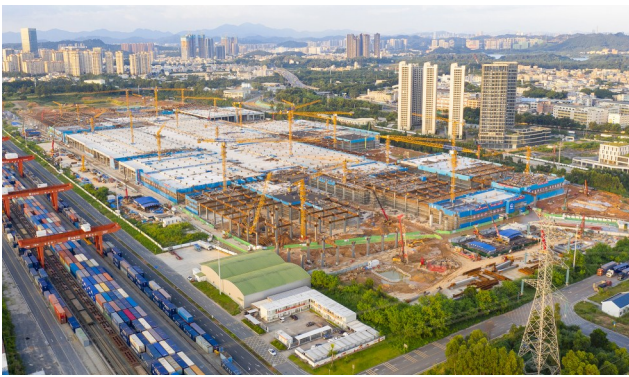
深圳平湖南综合物流枢纽中心主体盖板施工
