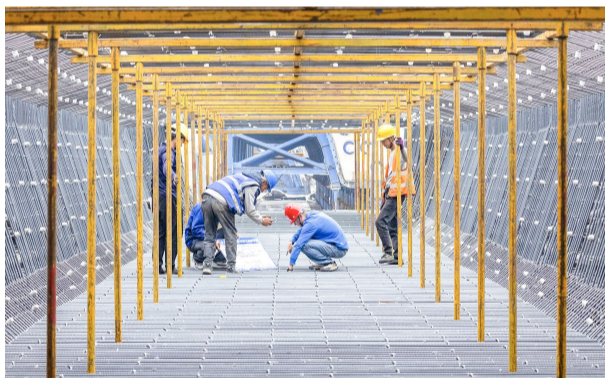
预制箱梁钢筋绑扎施工
