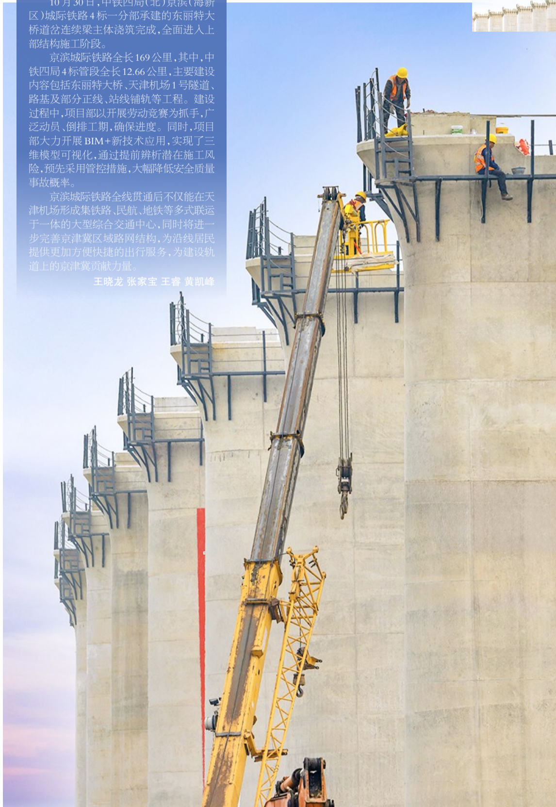
工人正在安装桥墩顶部护栏
