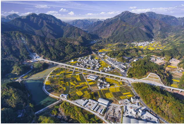
中铁四局承建的昌景黄铁路休宁河特大桥
