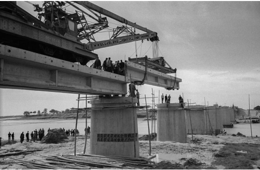
滁阜铁路冯河大桥架梁施工现场,该桥于1970年10月1日胜利通车
