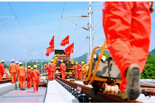
2022年6月8日,昌景黄高铁安徽段铺轨施工
