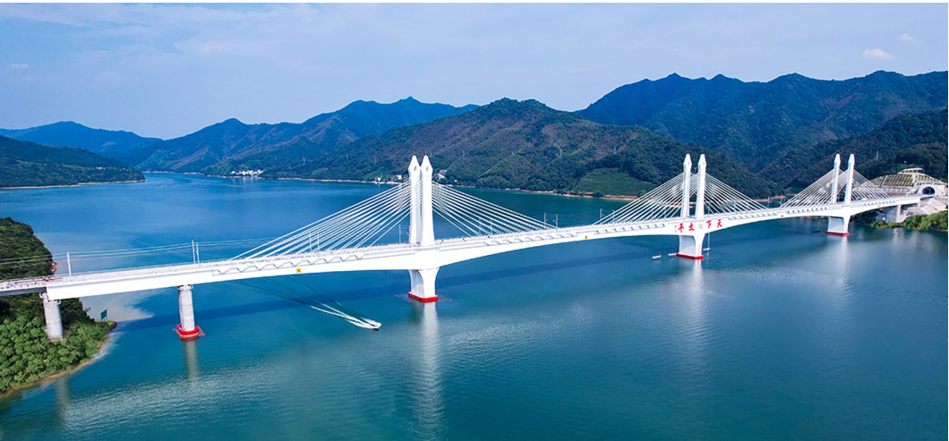
2024年4月26日,池黄高铁开通运营,图为池黄高铁太平湖大桥
