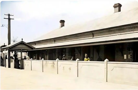
1912年11月,津浦铁路全线建成,当时的蚌埠车站
