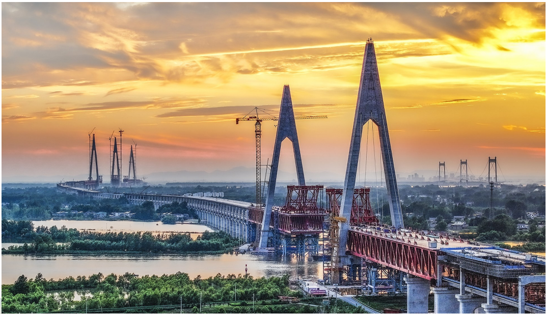
2024年7月,建设中的巢马城际铁路马鞍山长江公铁大桥副汉航道桥
