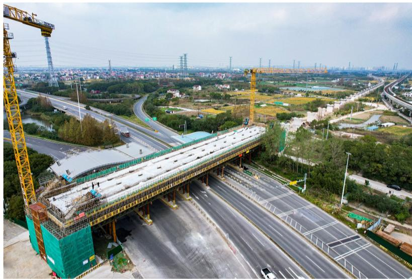
11月13日,中铁四局二公司承建的沪(上海)苏(州)(南)通铁路二期7标惠南特大桥跨东大公路112米系杆拱浇筑完成。沪苏通铁路全长143公里,设9座车站,设计时速200公里。7标管段长36.54公里,施工内容包括正线、动车走行线、上海动车所等。其中,惠南特大桥长15.5公里,跨东大公路112米系杆拱采用支架法“先梁后拱”现浇施工。
