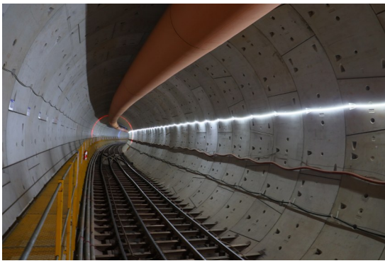
狮山1号隧道盾构区间
