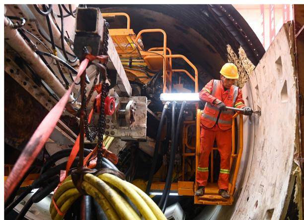
工人正在固定管片螺栓
