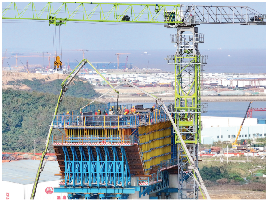
墩顶帽梁浇筑施工
