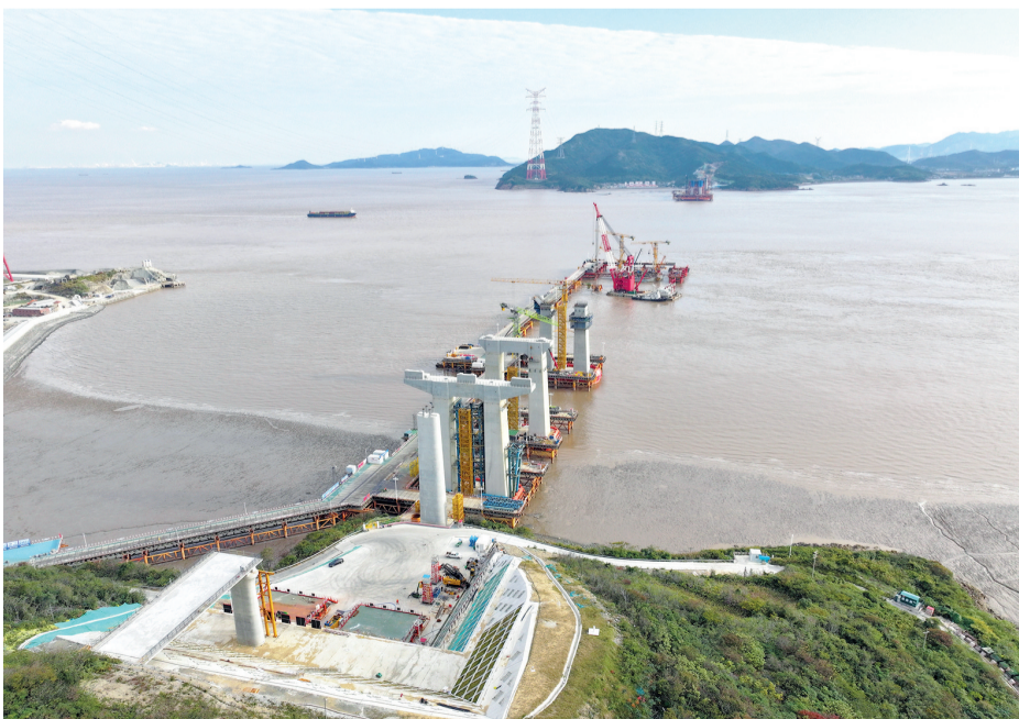
建设中的西堠门公铁两用大桥
