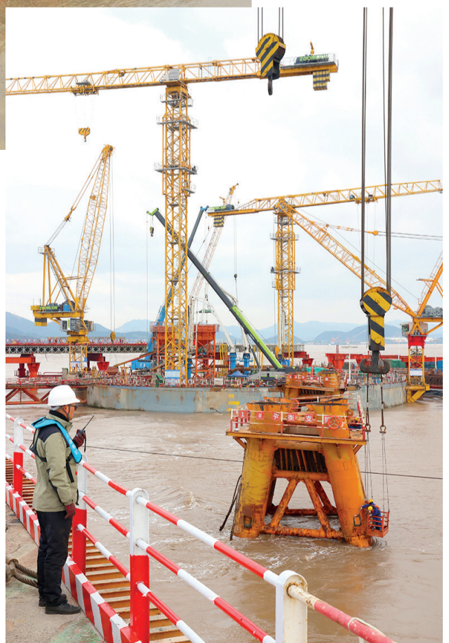
技术人员正在指挥临时栈桥拆除作业
