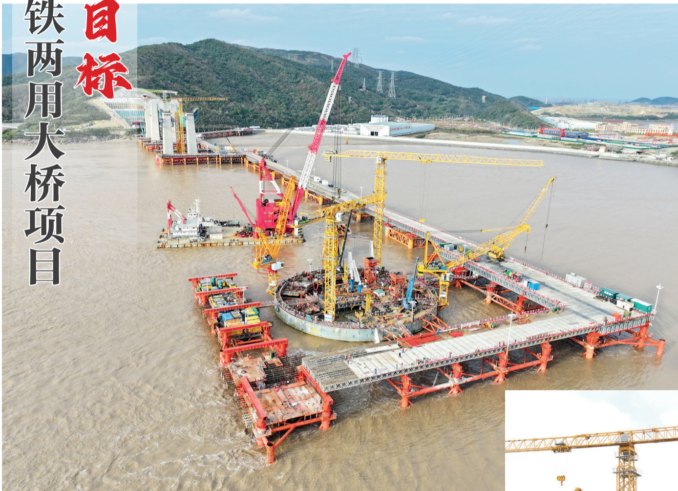
紧张有序的沉井施工现场
