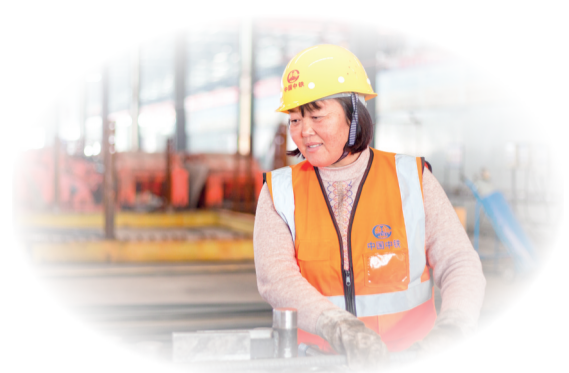
张满云正在进行钢筋加工作业
