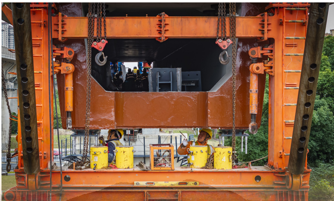
作业人员利用架桥机将箱梁运到既定位置
