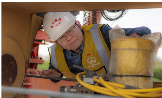
作业人员细致观察架桥机运作情况
