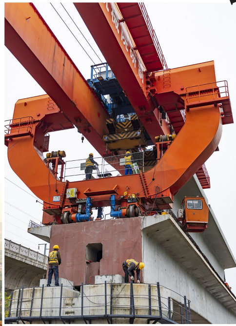
架桥机将箱梁稳稳架设至慈湖河特大桥上
