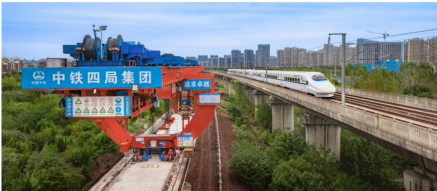
疾驰的高铁从建设现场穿过
