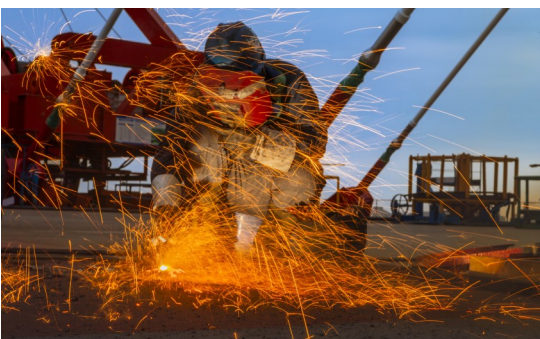
工人正在进行焊接作业
