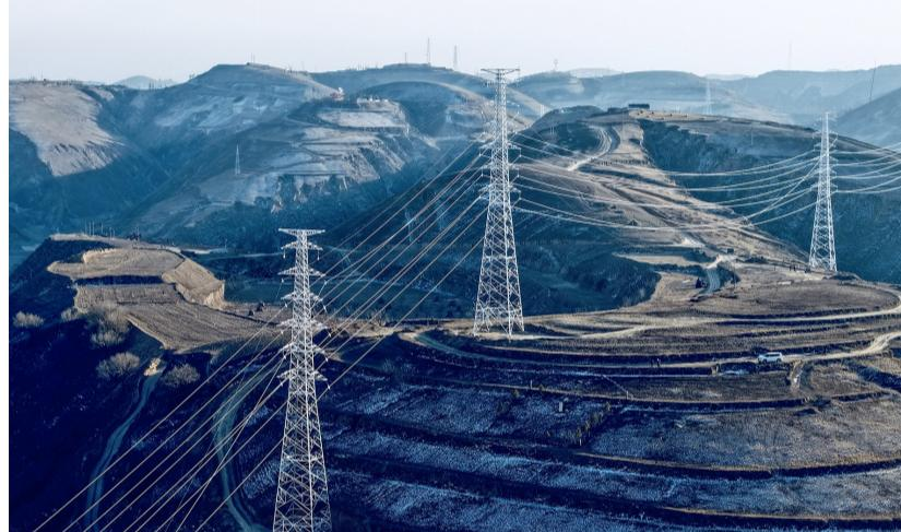
12月26日,中铁四局六公司承建的陕西华电新能源发电有限公司靖边县10万千瓦风电项目集电线路铁塔全部施工完成。该项目施工内容包括新建14台发电机组、38.6公里集电线路、141基铁塔等。
