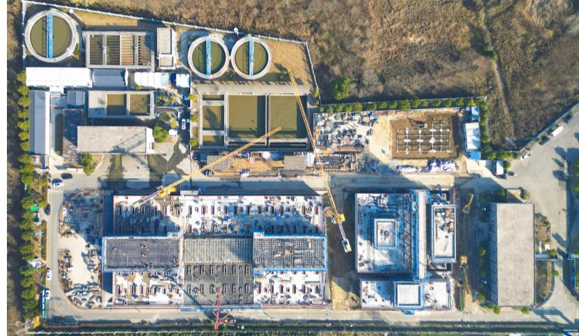
2024年12月29日,中铁四局市政公司承建的合肥三水厂深度处理工程最大规模单体——活性炭滤池主体结构封顶。该工程总建筑面积3908平方米,施工内容为新建40万立方米/日深度处理工艺,包含新建单体6座以及对原有构筑物进行改造。
