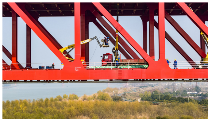
工人正在安装检查车轨道
