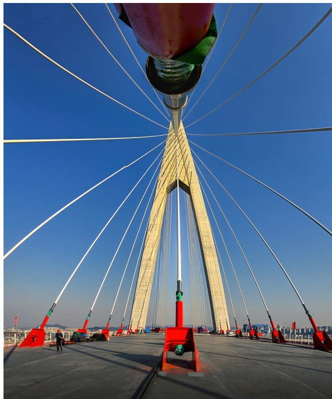
大桥采用2100兆帕高强耐候钢绞线斜拉索,是目前世界上桥梁用强度最高的钢绞线
