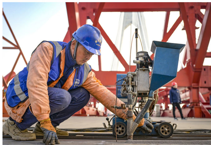
工人正在焊接桥面缝隙
