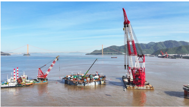
甬(宁波)舟(山)铁路西堠门公铁两用大桥4号主塔墩钢沉井下沉着床施工完成 杨海军摄
