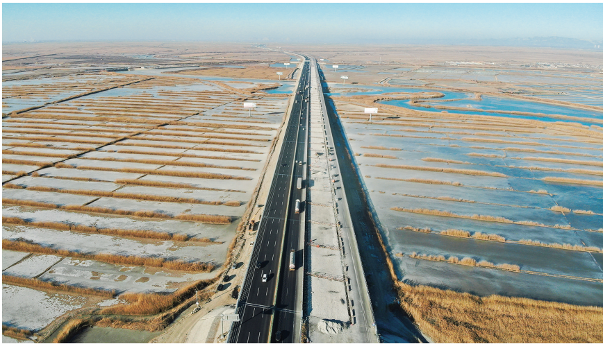
绕阳河特大桥北京方向桥面系施工
