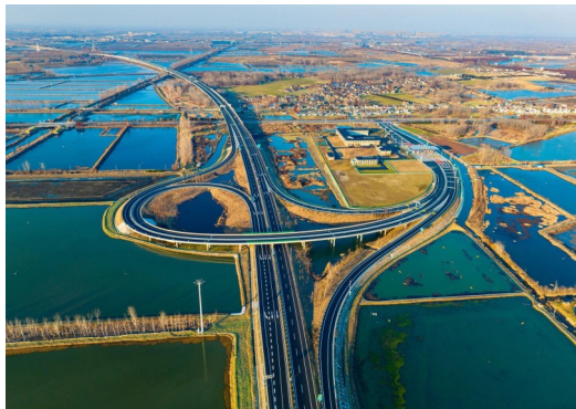
二公司参建阜宁至溧阳高速公路建湖至兴化段
