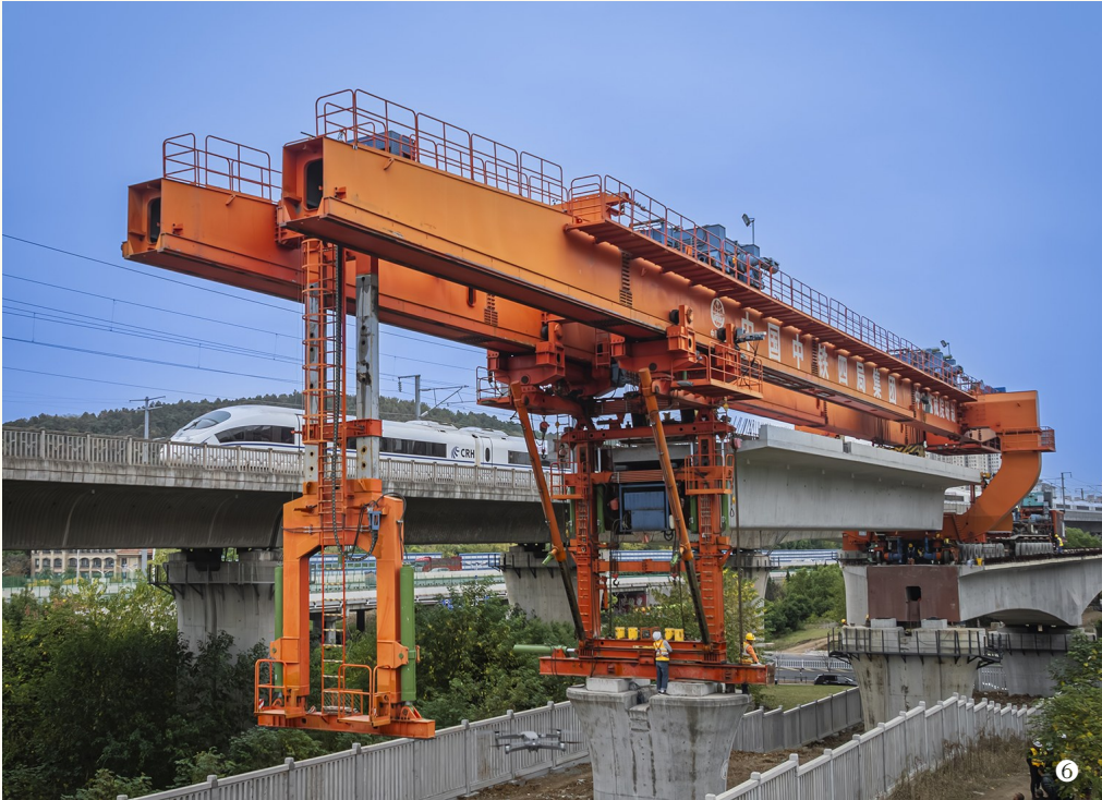
⑥架桥机作业正酣,一列高速列车从旁呼啸而过 ⑦段启楠与工作人员交流箱梁架设情况 ⑧段启楠在施工现场查看架桥机作业情况
