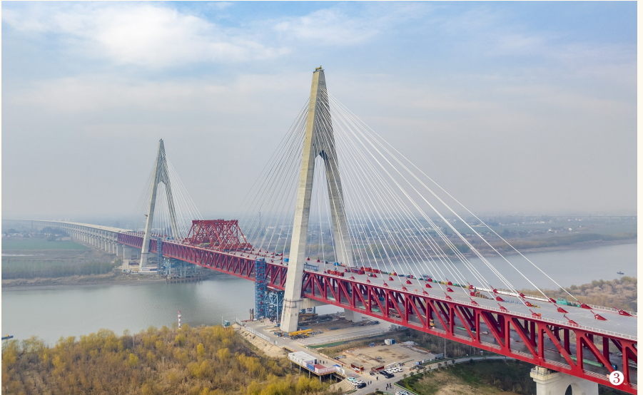
①熊秋虎在检查钢板厚度 ②熊秋虎在指导工人操作设备 ③建设中的巢马城际铁路马鞍山长江大桥副汉航道桥
