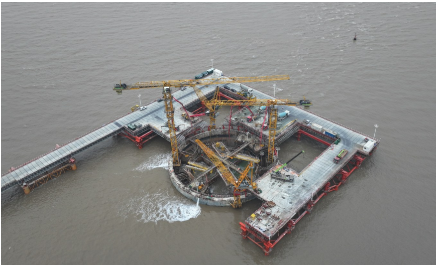
西堠门公铁两用大桥4号主塔嵌入式设置沉井基础浇筑施工
