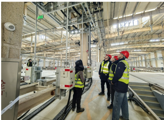
沈阳轨道交通1号线管理人员排查满堂停车场安全隐患
