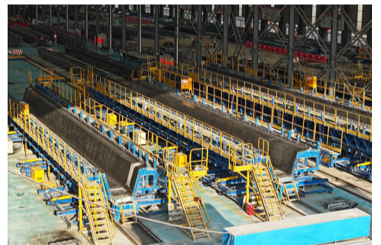
预制梁场环形生产线
